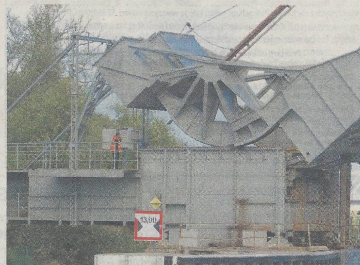
Zwodzone przęsło często ulega awariom.
