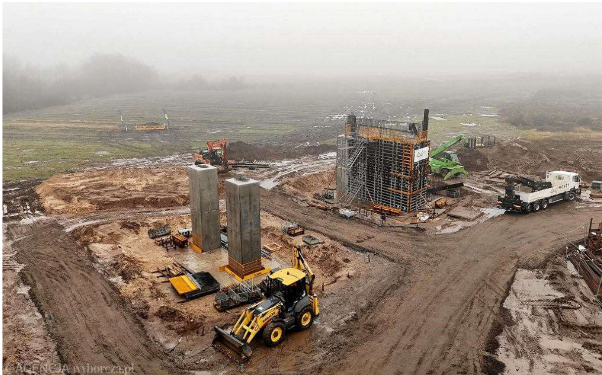
Budowa wiaduktu w ramach węzła drogowego Szczecin Południe na trasie rondo Hakena - autostrada A6. W tym miejscu zacznie się Zachodnia Obwodnica Szczecina Fot. Cezary Aszkiełowicz / Agencja Wyborcza.pl
