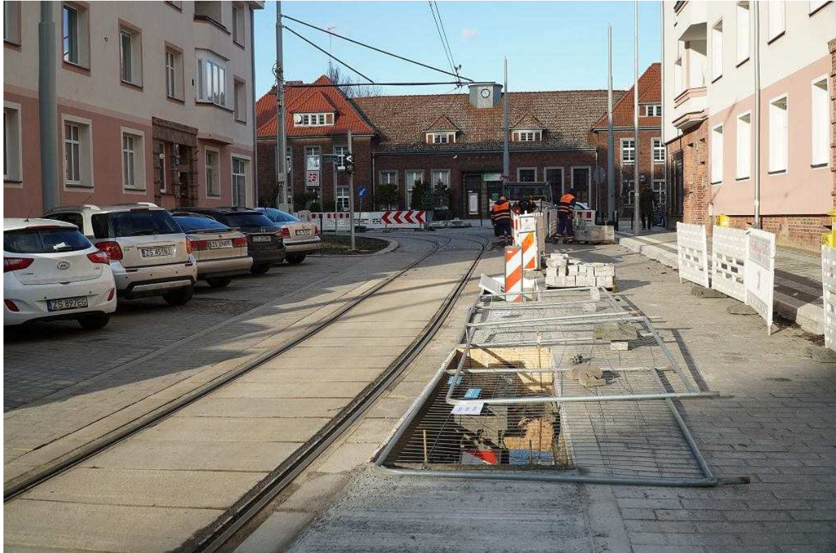
Prace przy wymianie zniszczonej nawierzchni przy torach obok Dworca Niebuszewo Andrzej Kraśnicki jr
