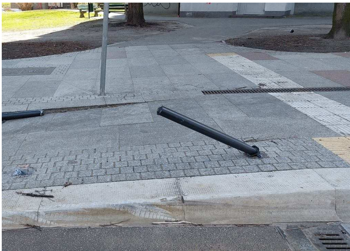
Zniszczone nowe słupki na Niebuszewie Tramwaje Szczecińskie
