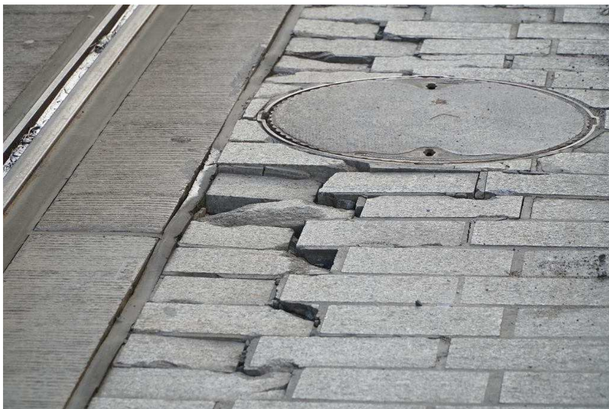
Zniszczona kostka przy torze w rejonie pętli Dworzec Niebuszewo Fot. Andrzej Kraśnicki jr
