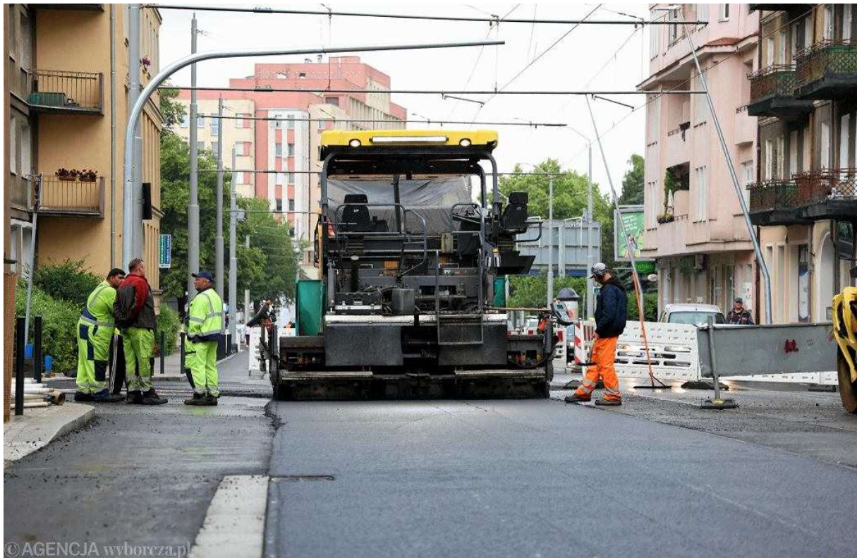
Wymiana torowisk i remont al. Wyzwolenia w Szczecinie. Asfaltowanie w rejonie ul. Felczaka Fot. Cezary Aszkielowicz / Agencja Wyborcza.pl
