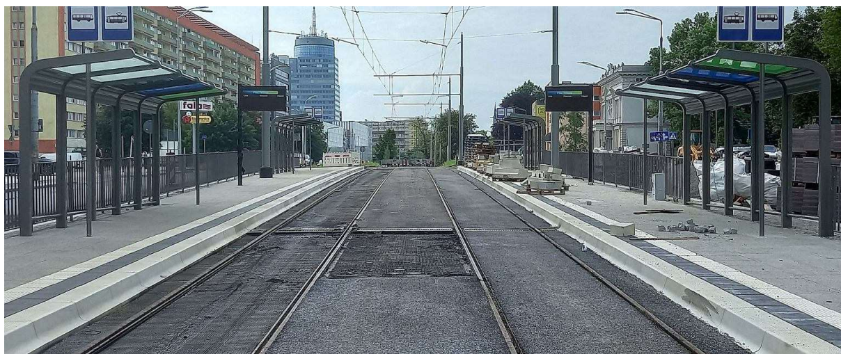
Wymiana torowiska i remont al. Wyzwolenia w Szczecinie. Gotowe przystanki 'Plac Witosa' (Piotr Szyliński)
