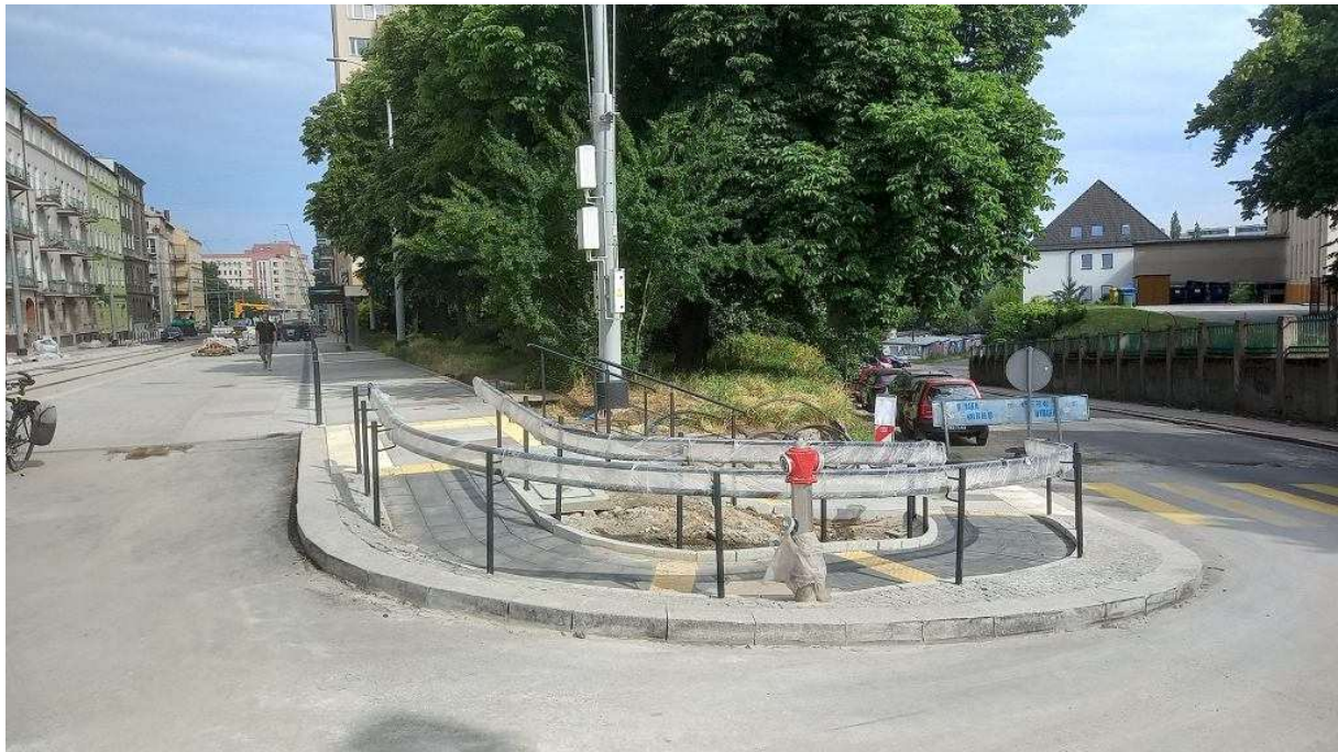
Wymiana torowiska i remont al. Wyzwolenia w Szczecinie. . Nowe schody i podjazd dla wózków przy ul. Lubomirskiego Piotr Szyliński
