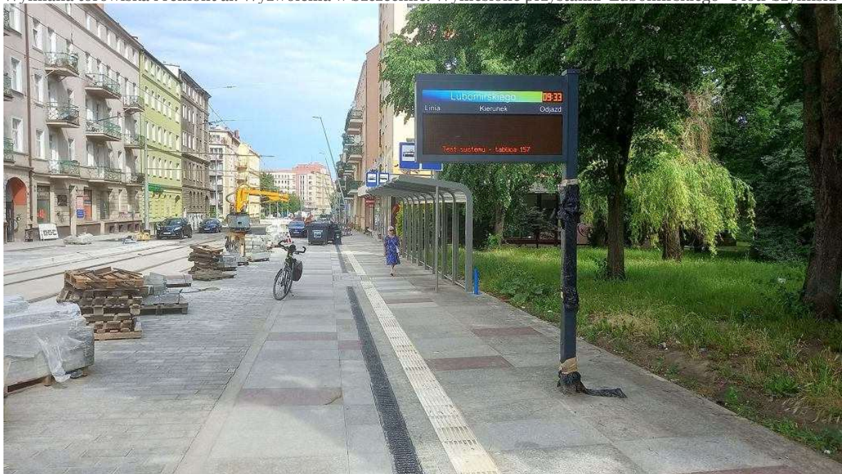
Wymiana torowiska i remont al. Wyzwolenia w Szczecinie. Przystanek 'Lubomirskiego', tablica już włączona. Droga rowerowa wyłożona płytami granitowymi Piotr Szyliński
