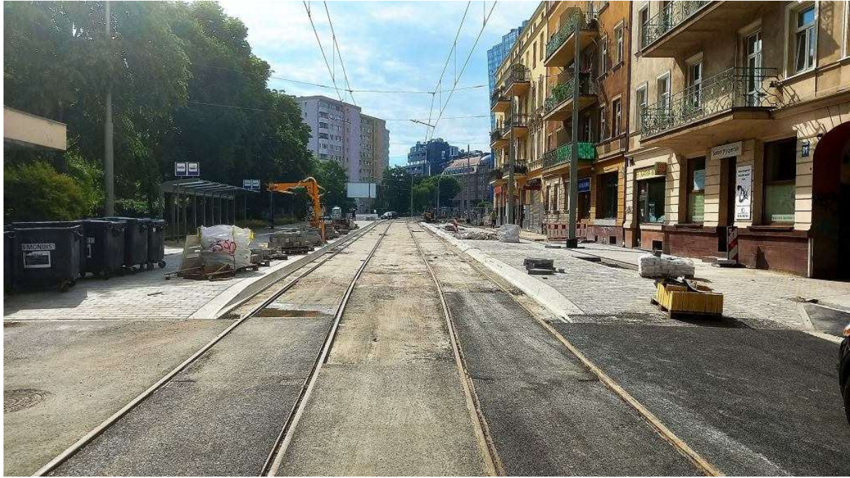
Wymiana torowiska i remont al. Wyzwolenia w Szczecinie. Wyniesione przystanki 'Lubomirskiego' Piotr Szyliński
