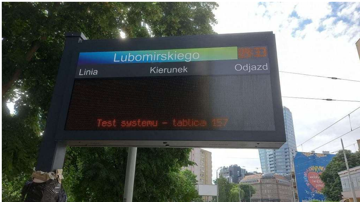
Wymiana torowiska i remont al. Wyzwolenia w Szczecinie. Na przystanku 'Lubomirskiego' trwa już testowanie tablic świetlnych Piotr Szyliński
