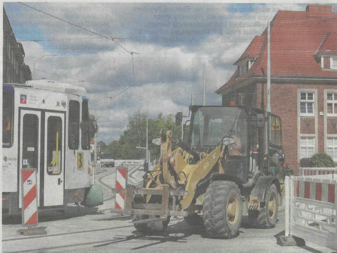
Niebuszewo Bolinka. Nowa pętla przy ul. Orzeszkowej z dochodzącymi do niej ulicami Asnyka i Boguchwały. Tramwaje kursują, ale wokół niej jeszcze plac budowy. Fot. Mirosław WINCONEK
