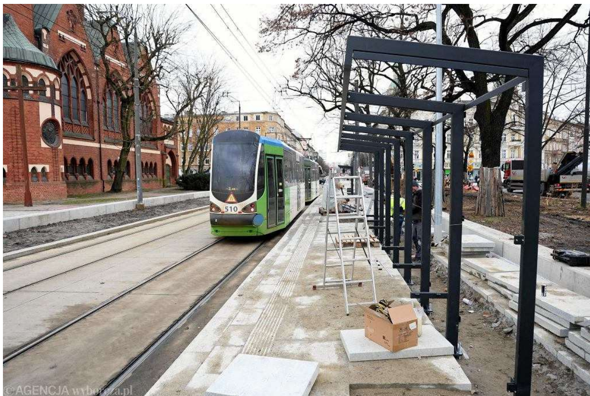
Przebudowa placu Zwycięstwa w Szczecinie. Budowa przystanku autobusowo-tramwajowego Fot. Cezary Aszkielowicz / Agencja Wyborcza.pl
