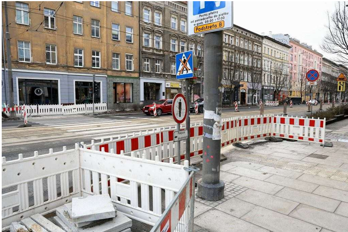
Przebudowa placu Zwycięstwa w Szczecinie. Zamknięte przejście przez ul. Krzywoustego Fot. Cezary Aszkielowicz / Agencja Wyborcza.pl
