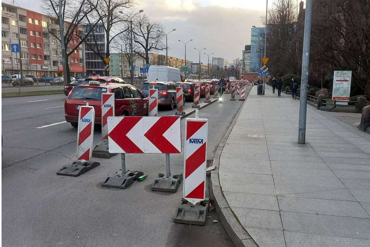
Przebudowa placu Zwycięstwa w Szczecinie. Nowa droga rowerowa wzdłuż al. Niepodległości w kierunku Bramy Portowej Piotr Szyliński
