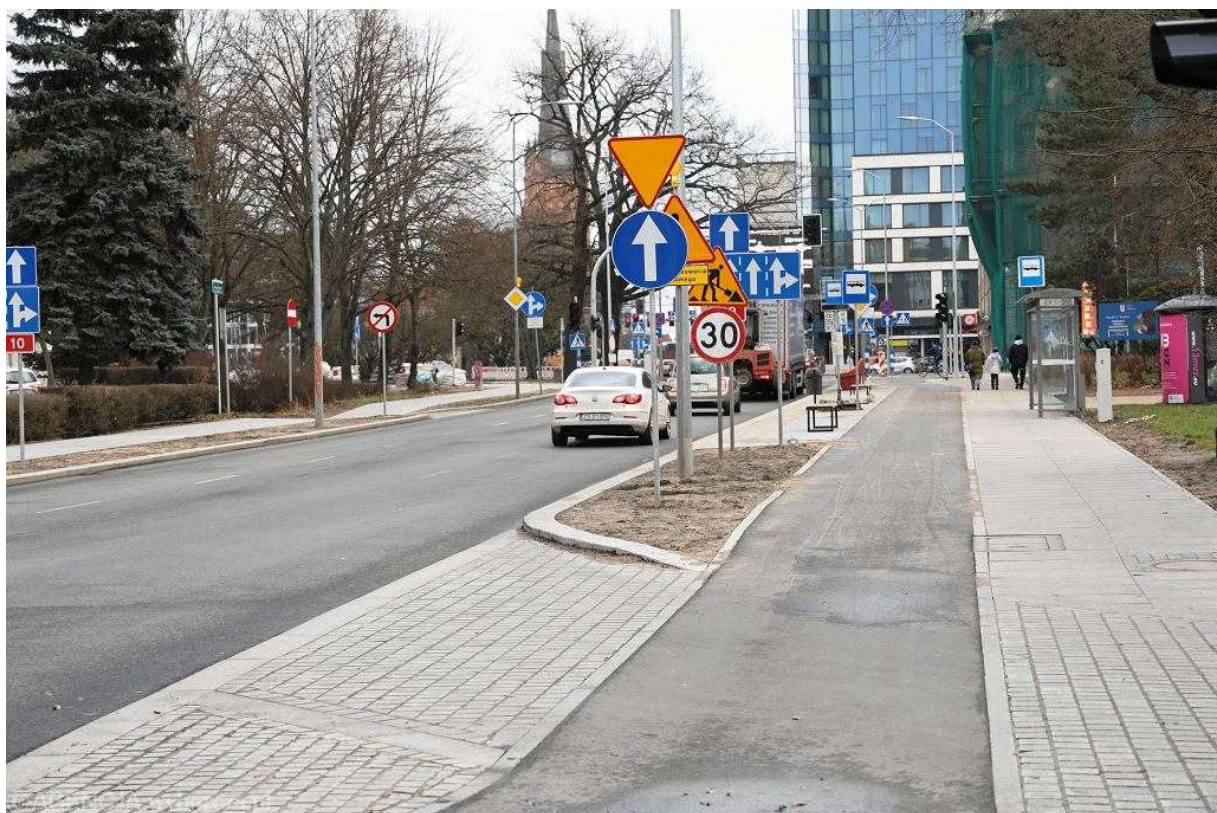
Przebudowa placu Zwycięstwa w Szczecinie. Nowa droga rowerowa po stronie południowej Fot. Cezary Aszkielowicz / Agencja Wyborcza.pl
