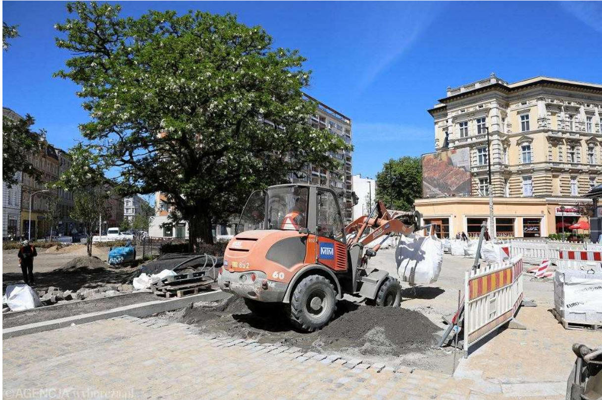
Plac Zgody w Szczecinie. Trwa układanie nawierzchni z kostki Fot. Cezary Aszkielowicz / Agencja Wyborcza.pl
