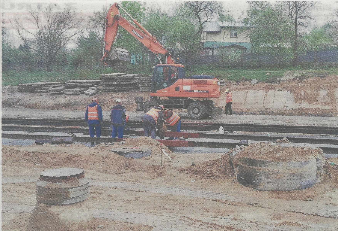
Widać postęp prac przy przebudowie ul. Władysława Szafera i budowie torowiska na nowej trasie tramwajów.
