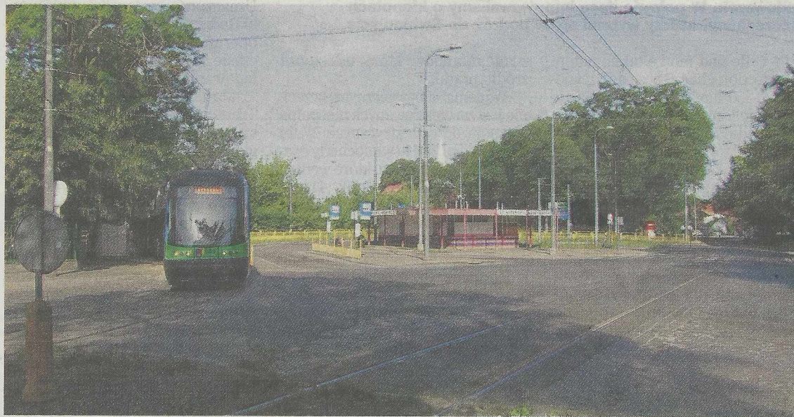
Rejon skrzyżowania ulic Żołnierskiej i Sebastiana Klonowica z pętlą. Tu też przez dłuższy czas po kolejnej inwestycji nową trasą od ul. Władysława Szafera docierać będą tramwaje.
