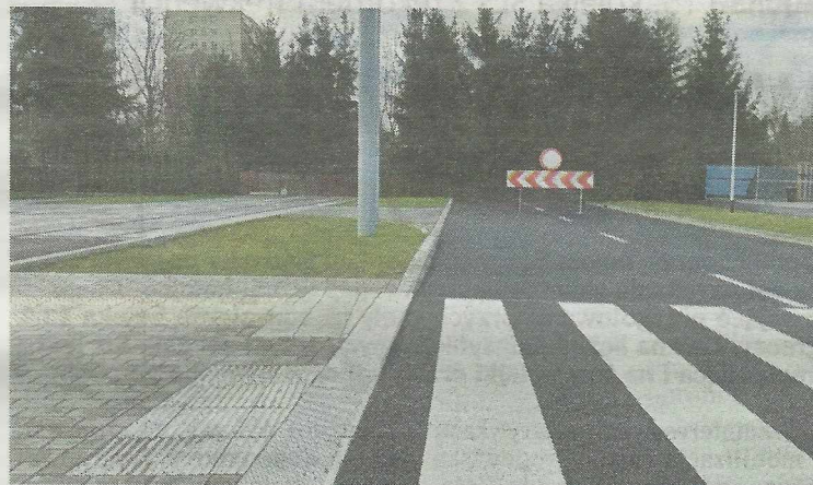
Kraniec ul. Szafera za skrzyżowaniem z ul. Romera. Nowe nitki dwóch jej jezdni i torowiska na razie kończą się w polu za rondem Żołnierzy Polskich Misji Pokojowych ONZ.
