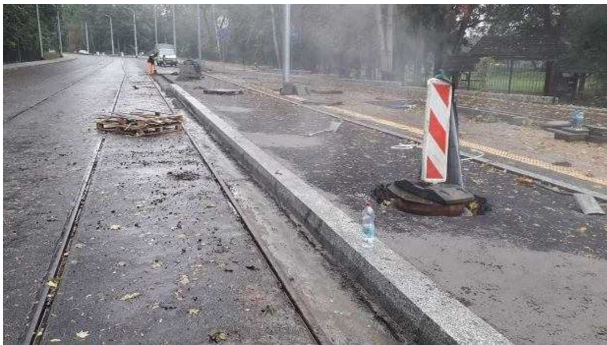
Prace przy ul. Arkońskiej Urząd Miasta
