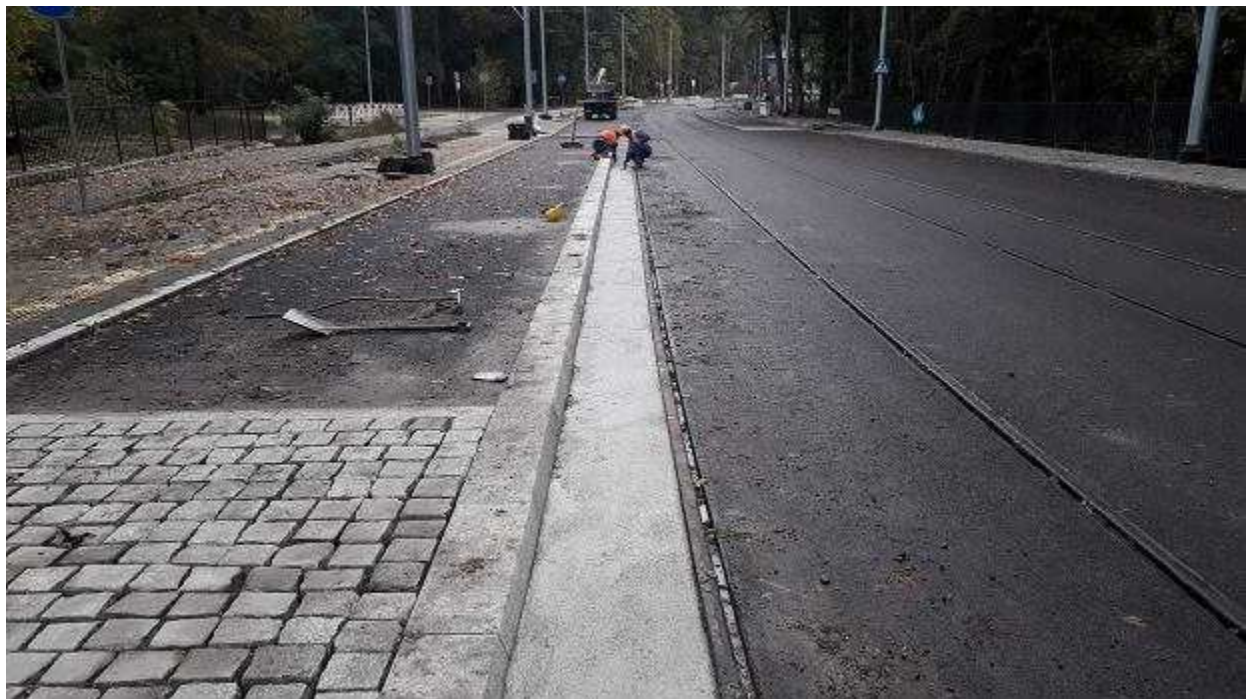
Prace przy ul. Arkońskiej Urząd Miasta
