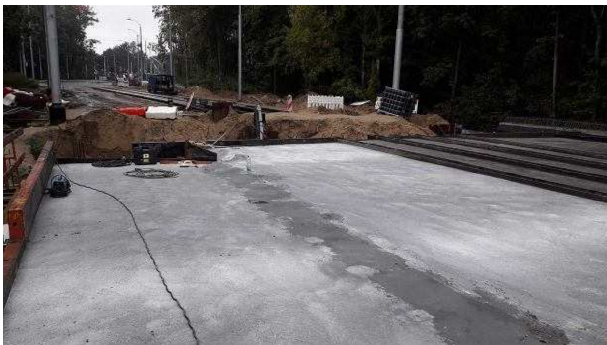
Gotowa płyta wiaduktu w ciągu ulicy Arkońskiej Urząd Miasta
