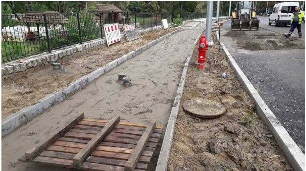
Prace przy ul. Arkońskiej Urząd Miasta
