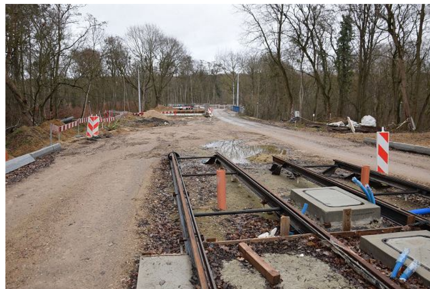
Odcinek, na którym prace budowlane przerwano z powodu problemów z wiaduktem Andrzej Kraśnicki jr
