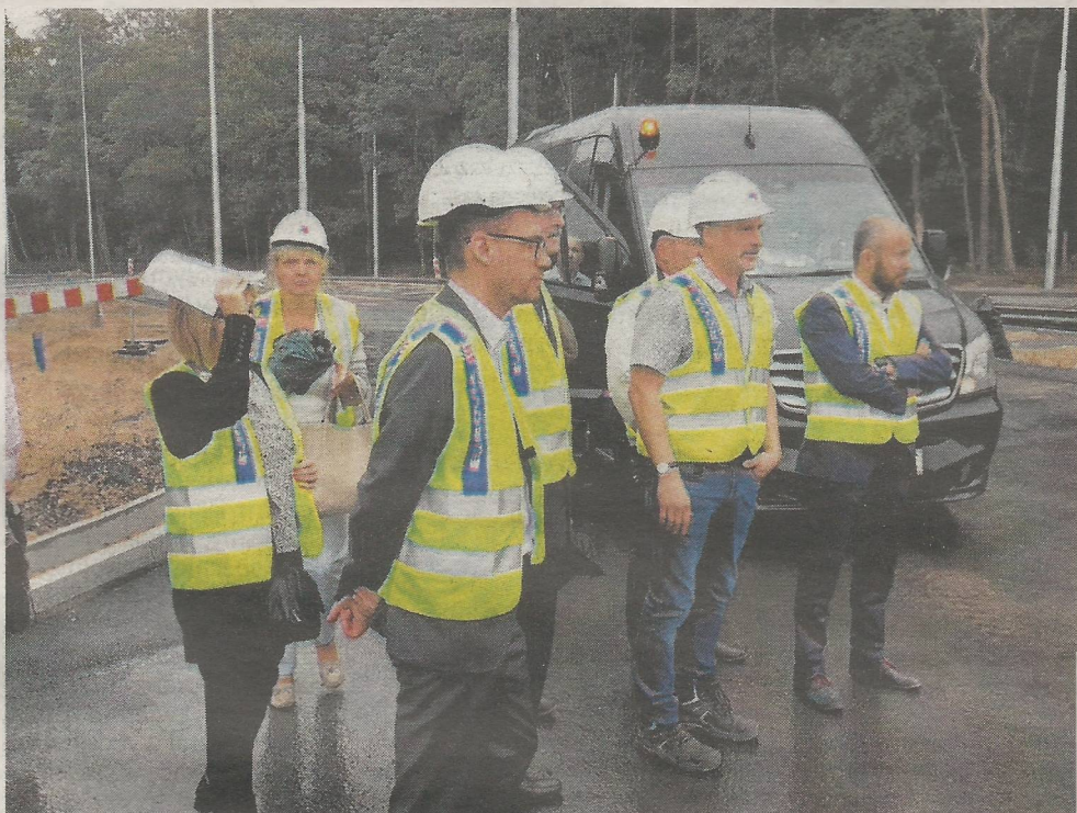
Radni odwiedzili plac budowy na ul. Arkońskiej. Deszczowa pogoda trochę przeszkodziła
