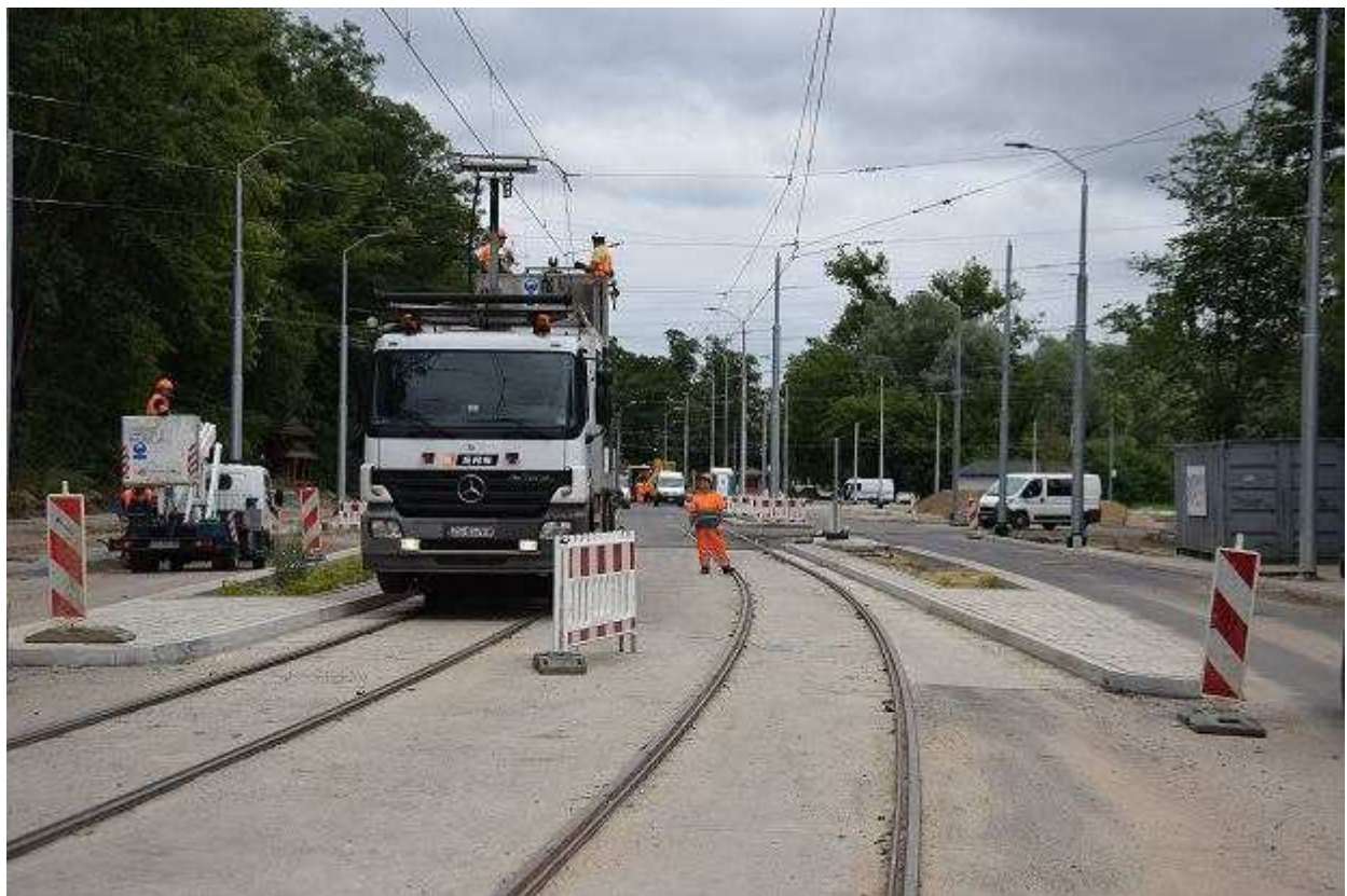
PKP Energetyka montuje sieć w pobliżu pętli Las Arkoński Andrzej Kraśnicki jr
