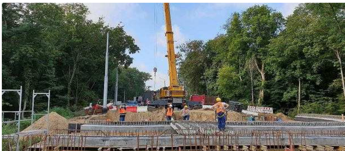
Modernizacja ulicy Arkońskiej. Połowa września 2019. Budowa nowego wiaduktu Urząd Miasta
