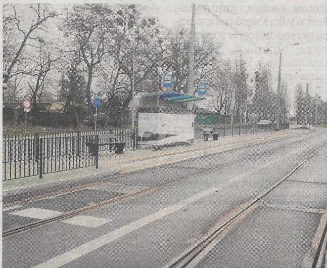
Jezdnia ulicy, torowisko, sieć - widać rychły koniec prac przy przebudowie ulicy Arkońskiej
