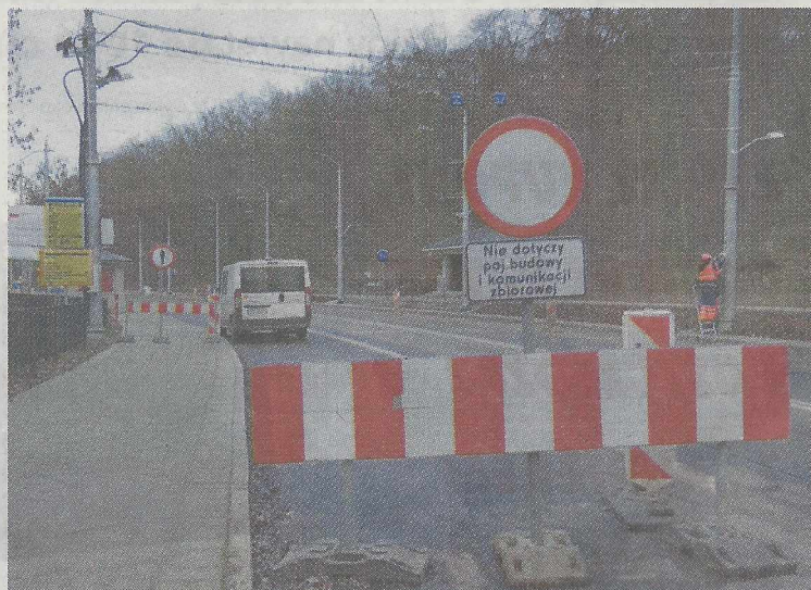
Przebudowa ulicy Arkońskiej w Szczecinie weszła w końcową fazę.
