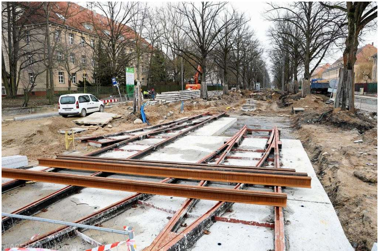
Drugi i trzeci etap przebudowy ul. Szafera, czyli budowa brakującego odcinka ul. Sosabowskiego w Szczecinie. Skrzyżowanie z ul. Żołnierską Fot. Cezary Aszkielowicz / Agencja Wyborcza.pl
