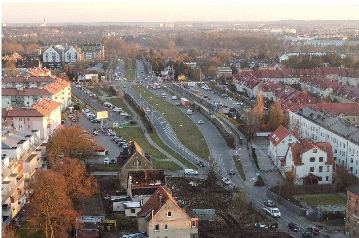
Istniejący odcinek ulicy Sosabowskiego. Widać ekrany dźwiękochłonne Andrzej Kraśnicki jr
