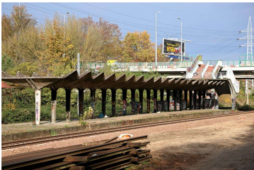
Zabytkowa wiatka będzie częścią przystanku SKM Pogodno. Prace wokół już trwają (Fot. Cezary Aszkielowicz / Agencja Wyborcza.pl)
