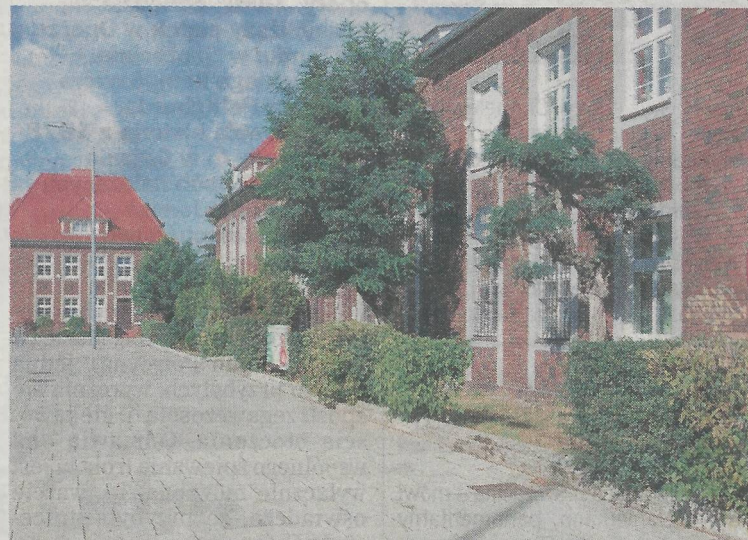
Budynek stacji Szczecin-Niebuszewo trzyma się całkiem nieźle. Fot. Ryszard PAKIESER
