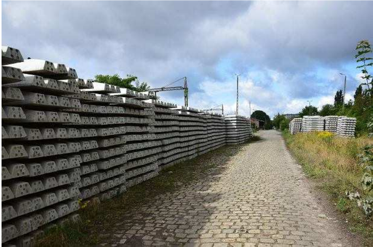
Budowa Szczecińskiej Kolei Metropolitalnej jest zagrożona. Nowe podkłady zgromadzone przy stacji Szczecin Niebuszewo Andrzej Kraśnicki jr
