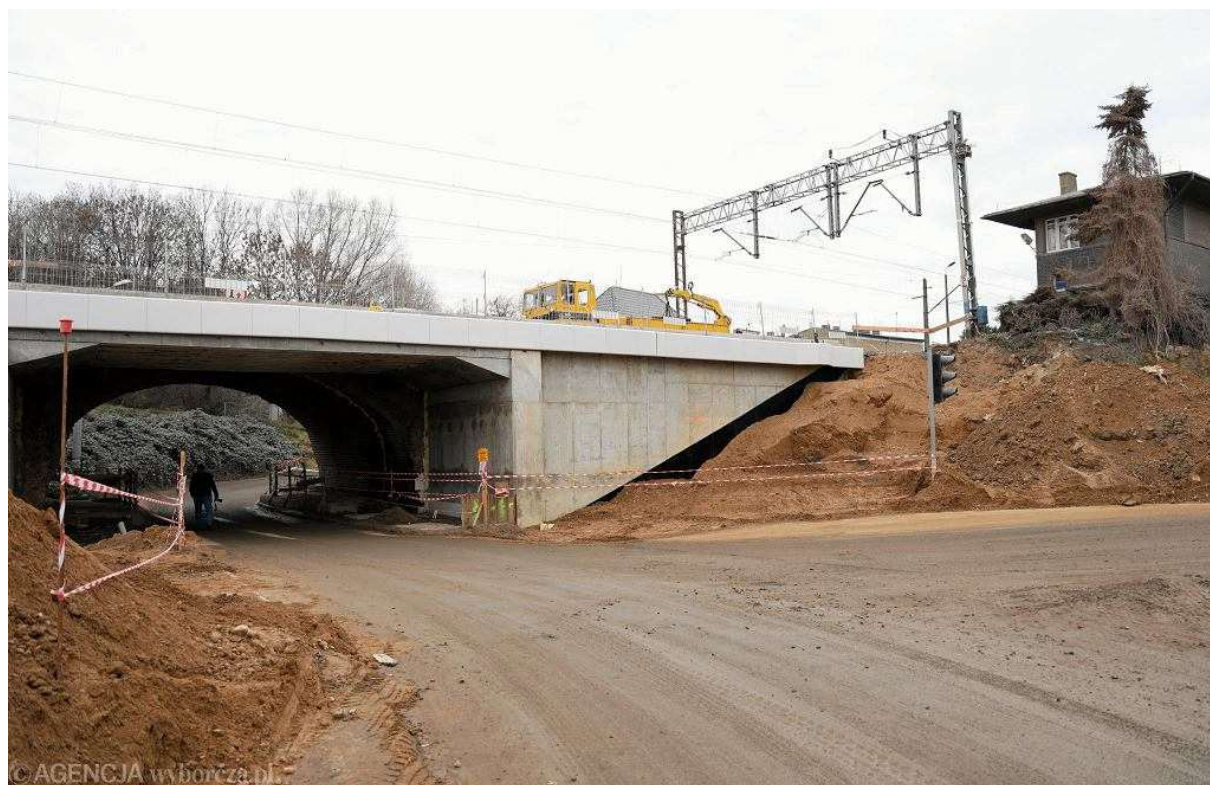
Szczecin Stołczyn. Budowa nowego wiaduktu kolejowego Fot. Cezary Aszkiełowicz / Agencja Wyborcza.pl
