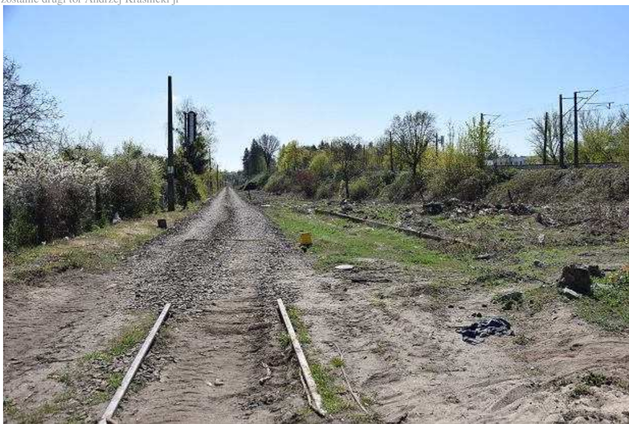
Przygotowania do budowy Szczecińskiej Kolei Metropolitalnej. Druga połowa kwietnia 2020. Rozebrany tor między Turzynem, a Pomorzanami. Zbudowana zostanie tu linia dwutorowa Andrzej Kraśnicki jr
