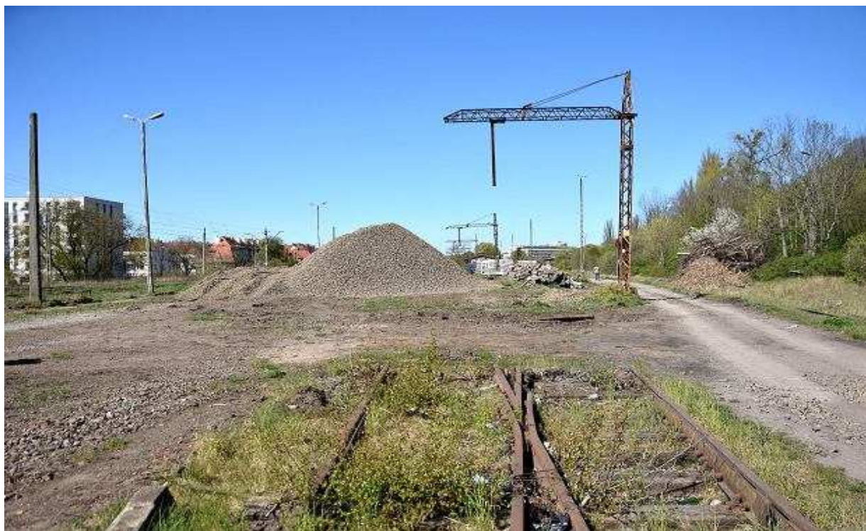
Przygotowania do budowy Szczecińskiej Kolei Metropolitalnej. Druga połowa kwietnia 2020. Ucięte tory towarowe na stacji Szczecin Niebuszewo Andrzej Kraśnicki jr
