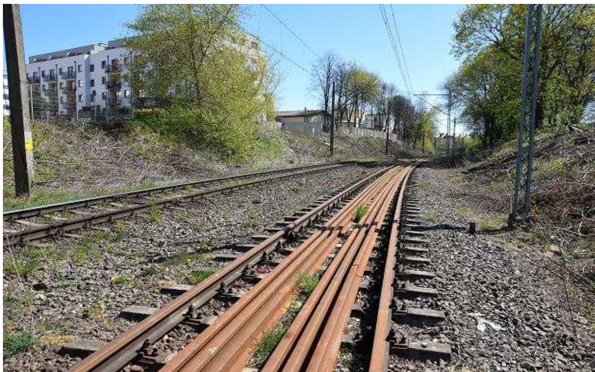
Przygotowania do budowy Szczecińskiej Kolei Metropolitalnej. Druga połowa kwietnia 2020. Nowe szyny na zamkniętym torze.
