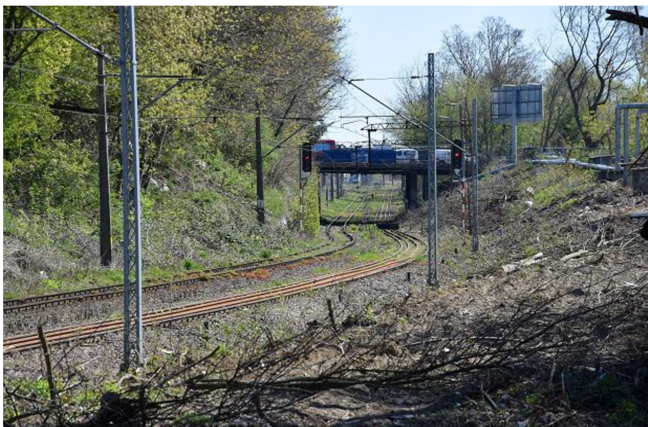
Przygotowania do budowy Szczecińskiej Kolei Metropolitalnej. Druga połowa kwietnia 2020. Wjazd w rejon stacji Szczecin Niebuszewo od strony ul. Niemierzyńskiej. Po prawej wycięte drzewa i krzewy Andrzej Kraśnicki jr
