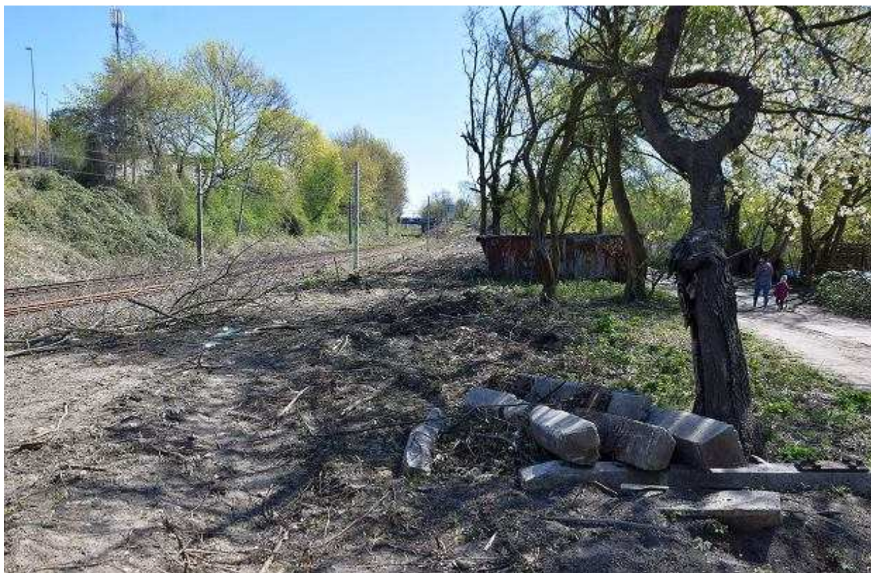
Przygotowania do budowy Szczecińskiej Kolei Metropolitalnej. Druga połowa kwietnia 2020. Wycięte drzewa wzdłuż szlaku kolejowego na Niebuszewie Andrzej Kraśnicki jr
