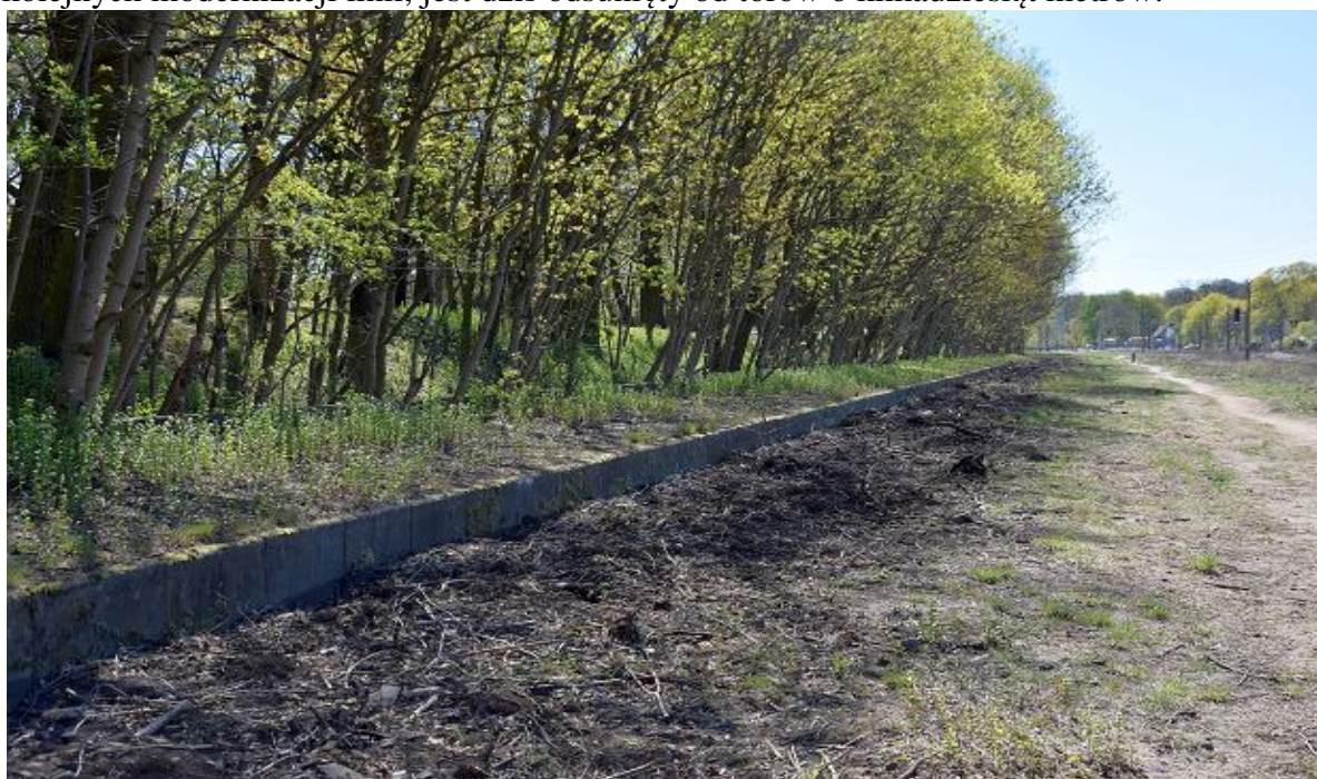
Przygotowania do budowy Szczecińskiej Kolei Metropolitalnej. Druga połowa kwietnia 2020. Pogodno. Krawędź dawnego peronu odsłonięcia po wycięciu krzaków Andrzej Kraśnicki jr
