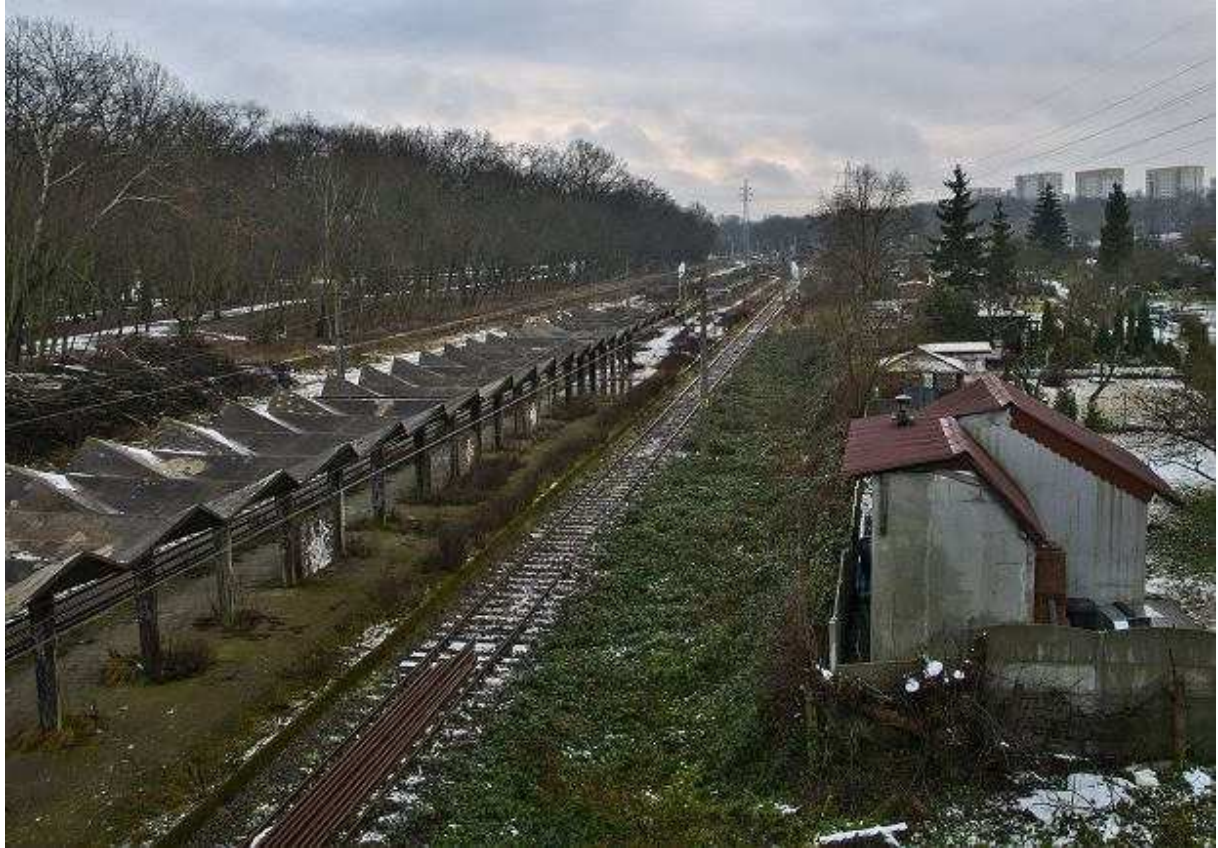
Szczecińska Kolej Metropolitalna w budowie. Stacja Pogodno Michał Kraśnicki
