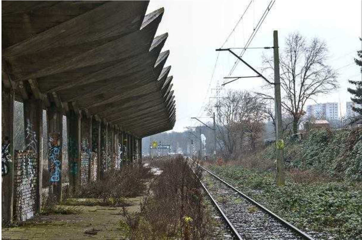
Szczecińska Kolej Metropolitalna w budowie. Stacja Pogodno Michał Kraśnicki
