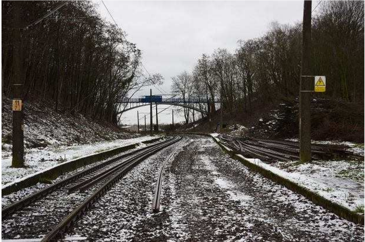
Szczecińska Kolej Metropolitalna w budowie. Gołęczin Andrzej Kraśnicki jr
