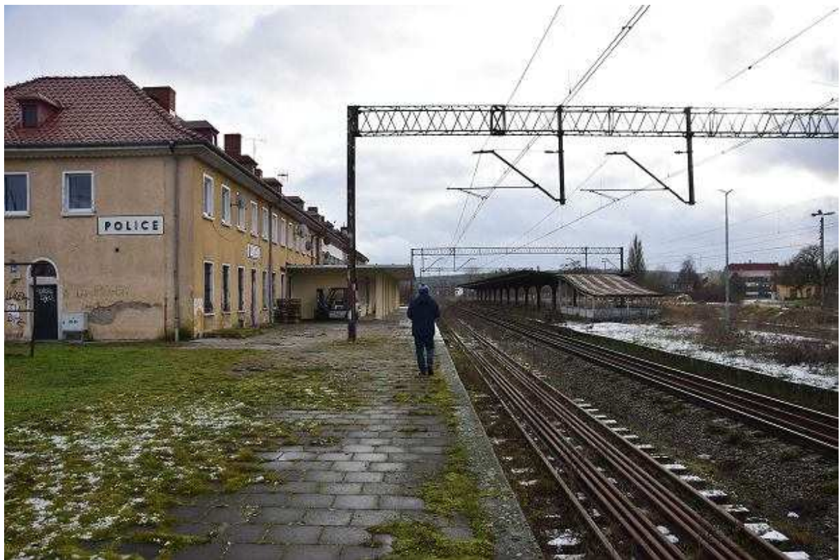
Szczecińska Kolej Metropolitalna w budowie. Police Andrzej Kraśnicki jr
