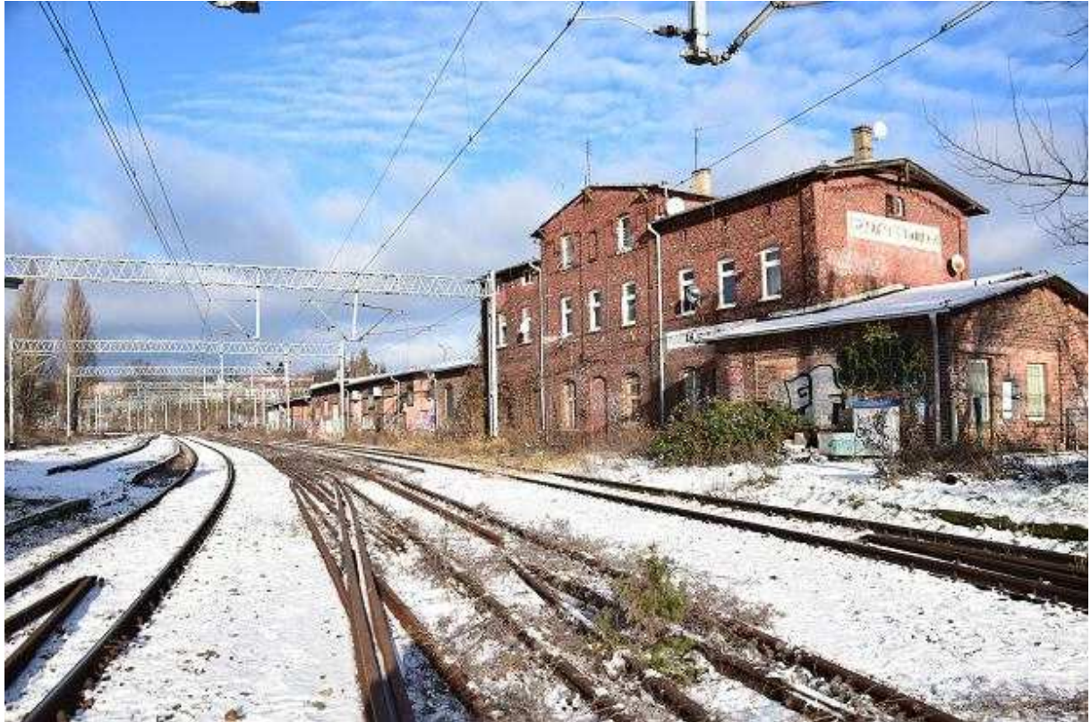
Szczecińska Kolej Metropolitalna w budowie. Turzyn Andrzej Kraśnicki jr
