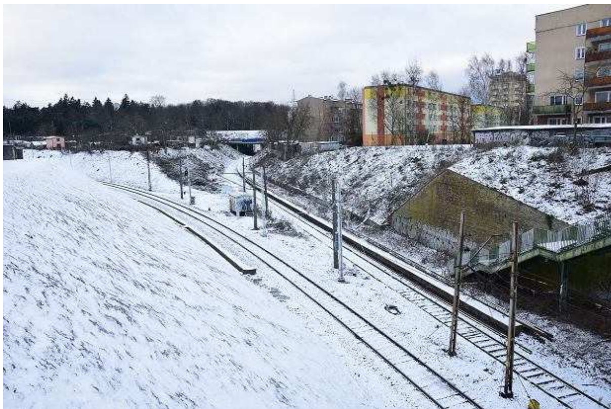
Szczecińska Kolej Metropolitalna w budowie. Stacja Pomorzany Andrzej Kraśnicki jr
