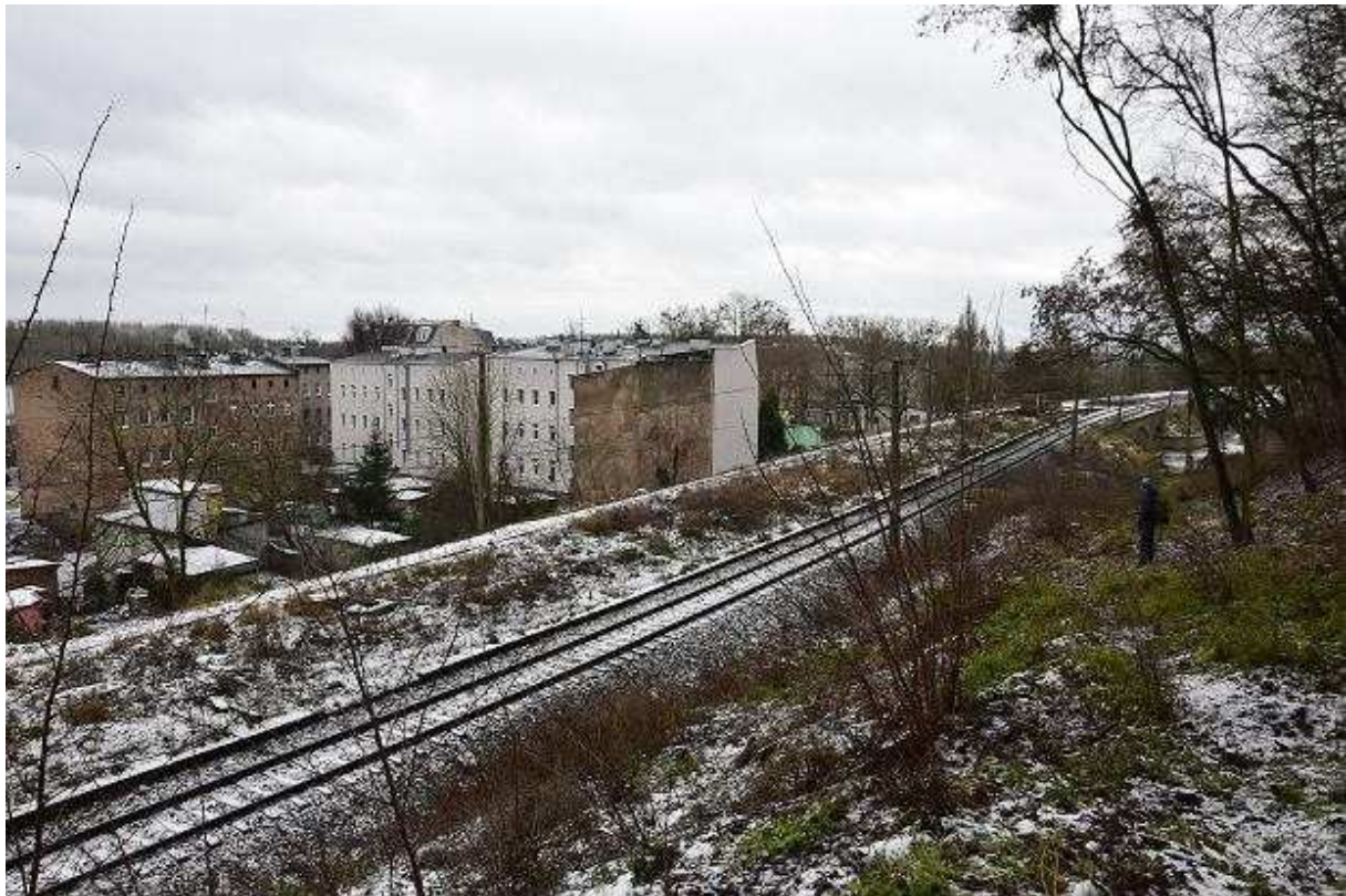
Szczecińska Kolej Metropolitalna w budowie. Goćław Andrzej Kraśnicki jr
