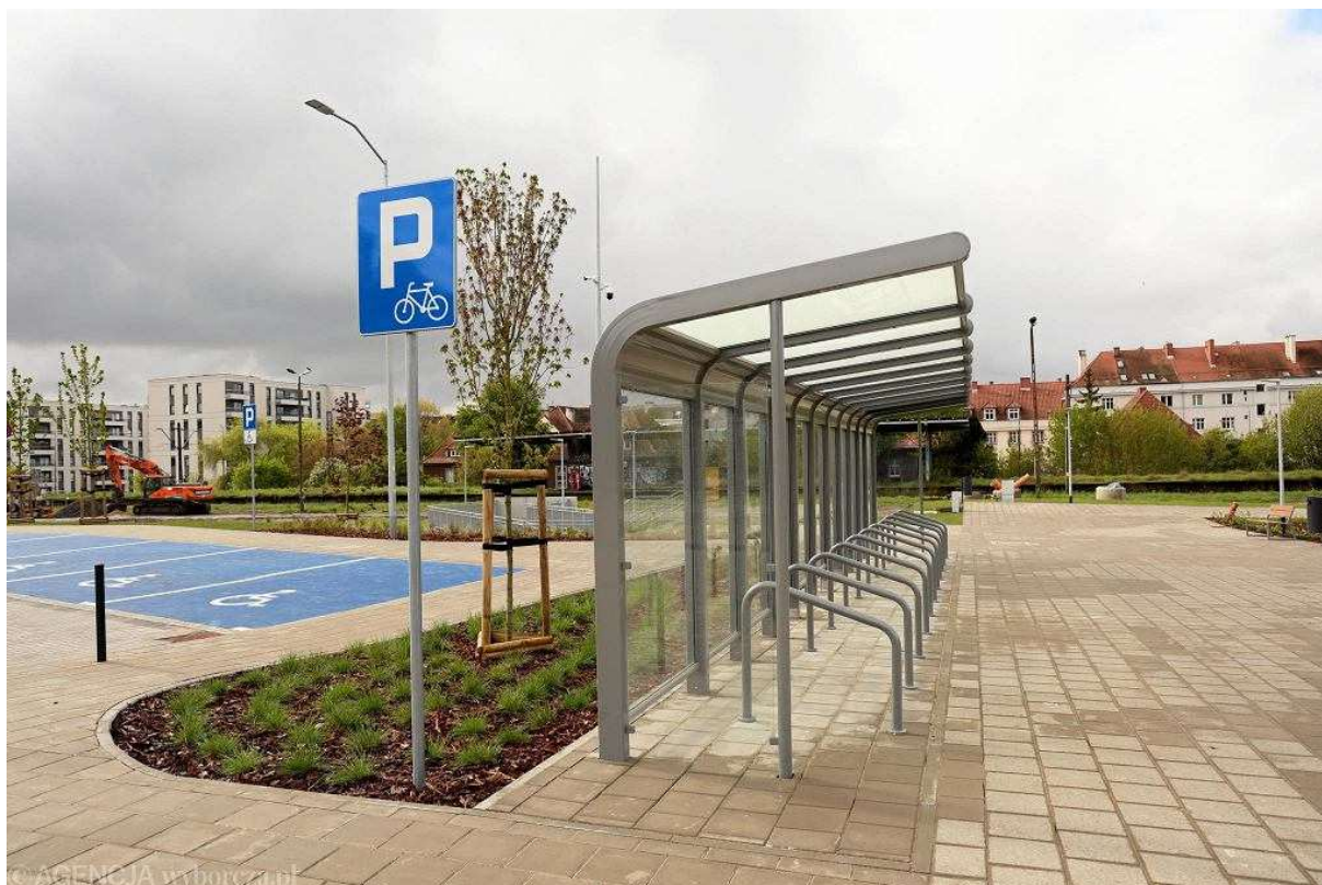
Nowy parking w rejonie przyszłej stacji Szczecińskiej Kolei Metropolitalnej Szczecin Niebuszewo Fot. Cezary Aszkielowicz / Agencja Wyborcza.pl
