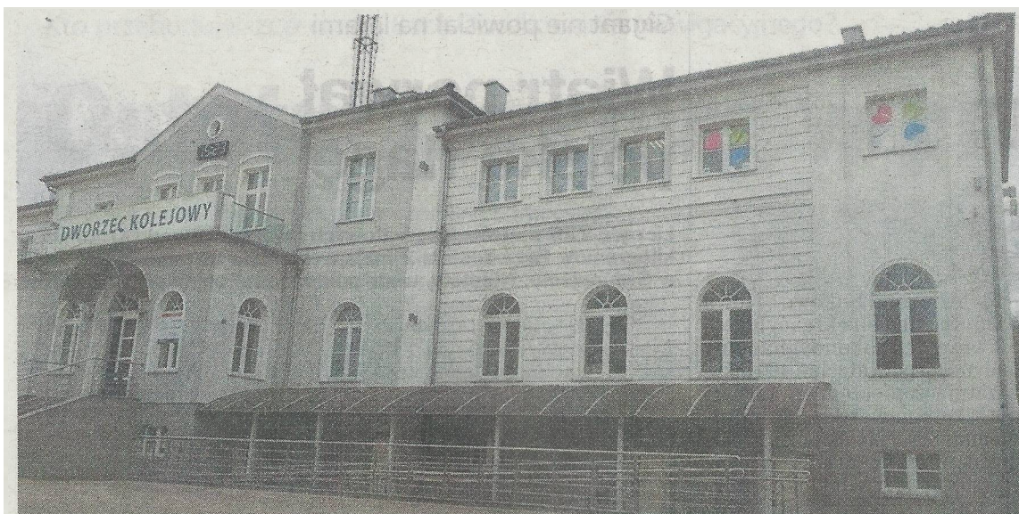
Wokół dworca kolejowego w Gryfinie powstanie całkowicie nowa infrastruktura, która ułatwić ma w przyszłości korzystanie ze Szczecińskiej Kolei Metropolitalnej. Niebawem rozpocznie się pierwszy etap przebudowy tej części miasta. Fot. Mirosław KWIATKOWSKI
