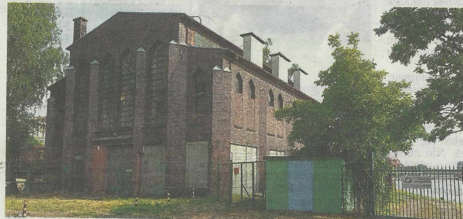
Zabytkowa stacja zasilania trakcji na Wyspie Jaskólczej. Poszukiwania wykonawcy, który ją zmodernizuje i odrestaurowuje, ciągle w toku.
