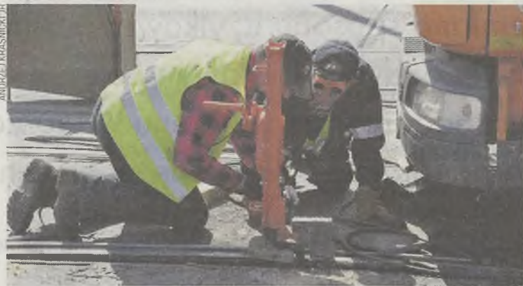
Naprawianie uszkodzonych torów
