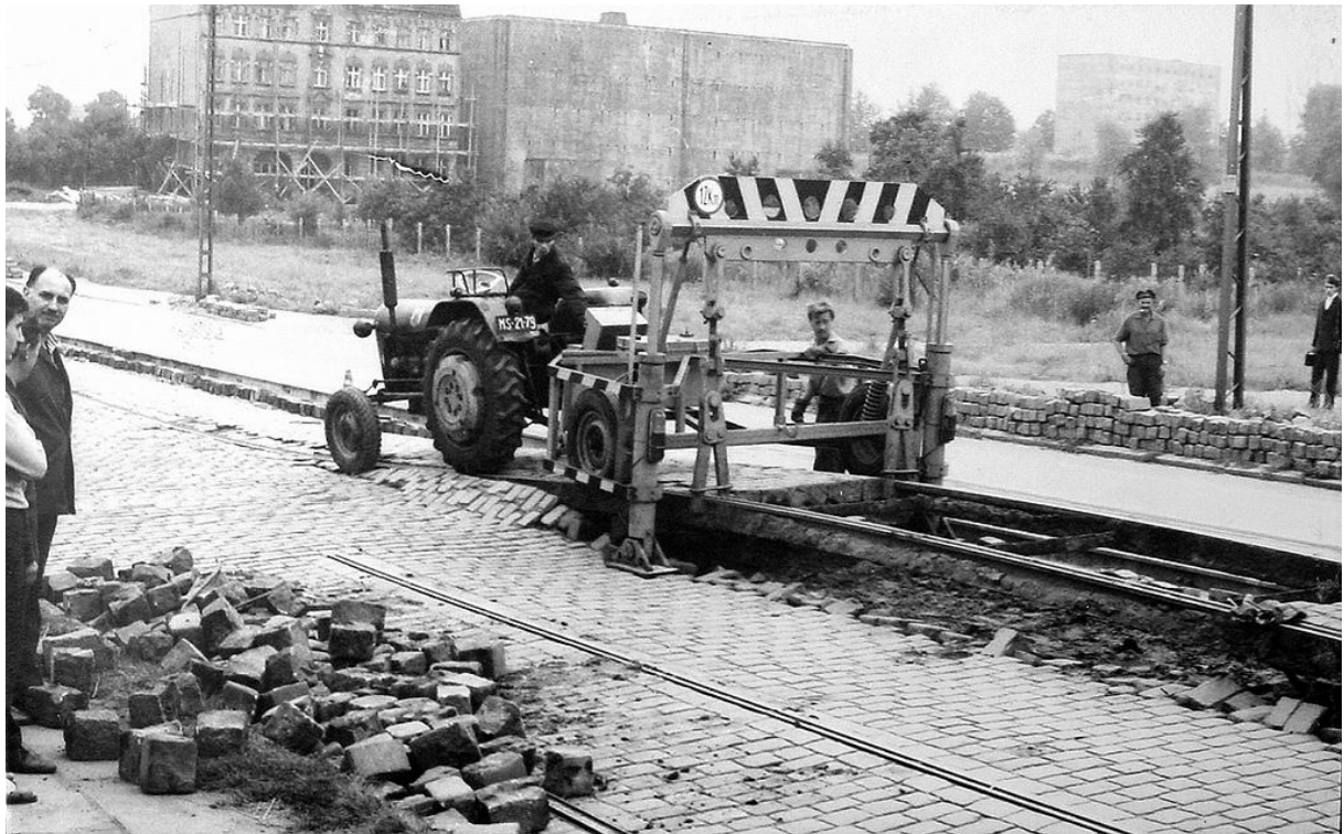
Lata 60. lub 70. demontaż poniemieckiego torowiska na ul. Dębogórskiej Archiwum ZDiTM
