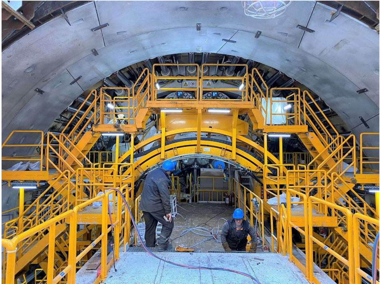
Marzec 2021. Maszyna drążąca 'Wyspiarka' rozpoczyna wiercenie tunelu pod Świną. Wokół pierwsze ułożone już pierścienie obudowy Piotr Flisiak PORR S.A.
