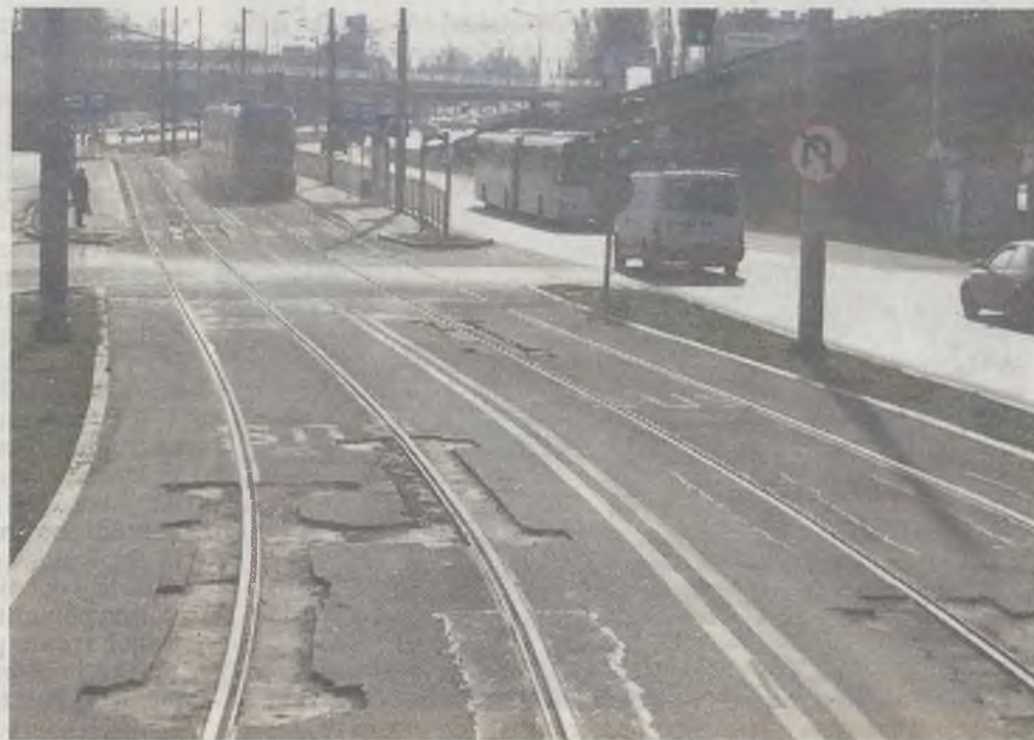
Nowe odkrywki i wciąż liczne ślady po tych wcześniejszych, czyli po naprawach, w nowych torowiskach na ulicach Energetyków i Gdańskiej aż do pętli „Basen Górniczy” w Szczecinie. Fot. Mirosław WINCONEK
