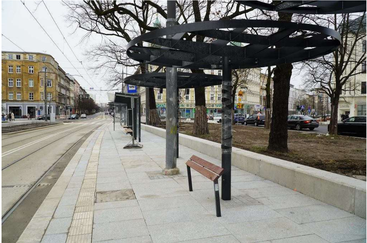
Nowy przystanek na pl. Zwycięstwa. Brakuje jeszcze elementów zadaszania na 'parasolach' nad oparciami fot. Andrzej Kraśnicki jr
