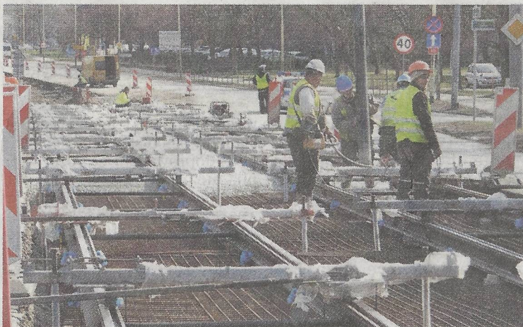
Prace przy torowisku tramwajowym w okolicach mostu Długiego są nieuniknione. Utrudnienia odczują nie tylko pasażerowie. Fot. Miroslaw WINCONEK
