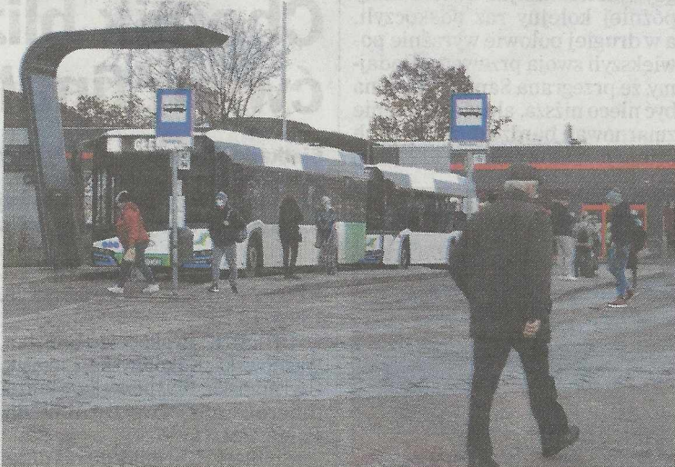
Pantografowe stacje szybkiego ładowania autobusów z napędem elektrycznym nadal w budowie. Najnowszy scenariusz zakłada, że zaczną one działać w drugim kwartale tego roku.
