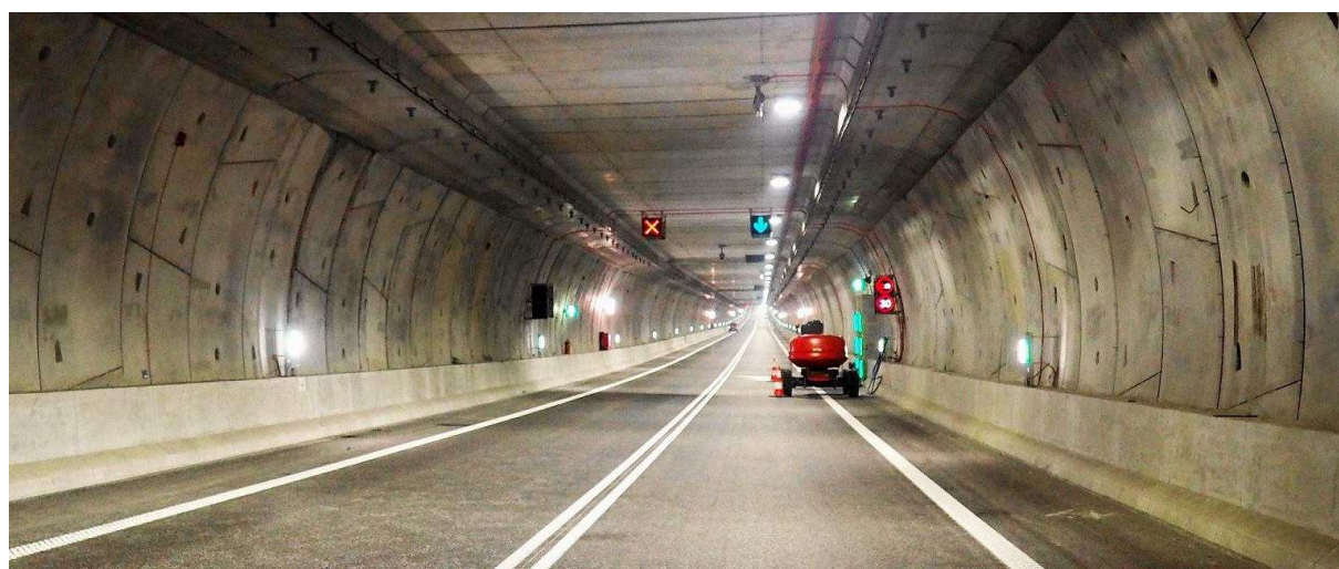
Tunel w Świnoujściu tuż przed otwarciem (Fot. tunel-swinoujscie.pl)
