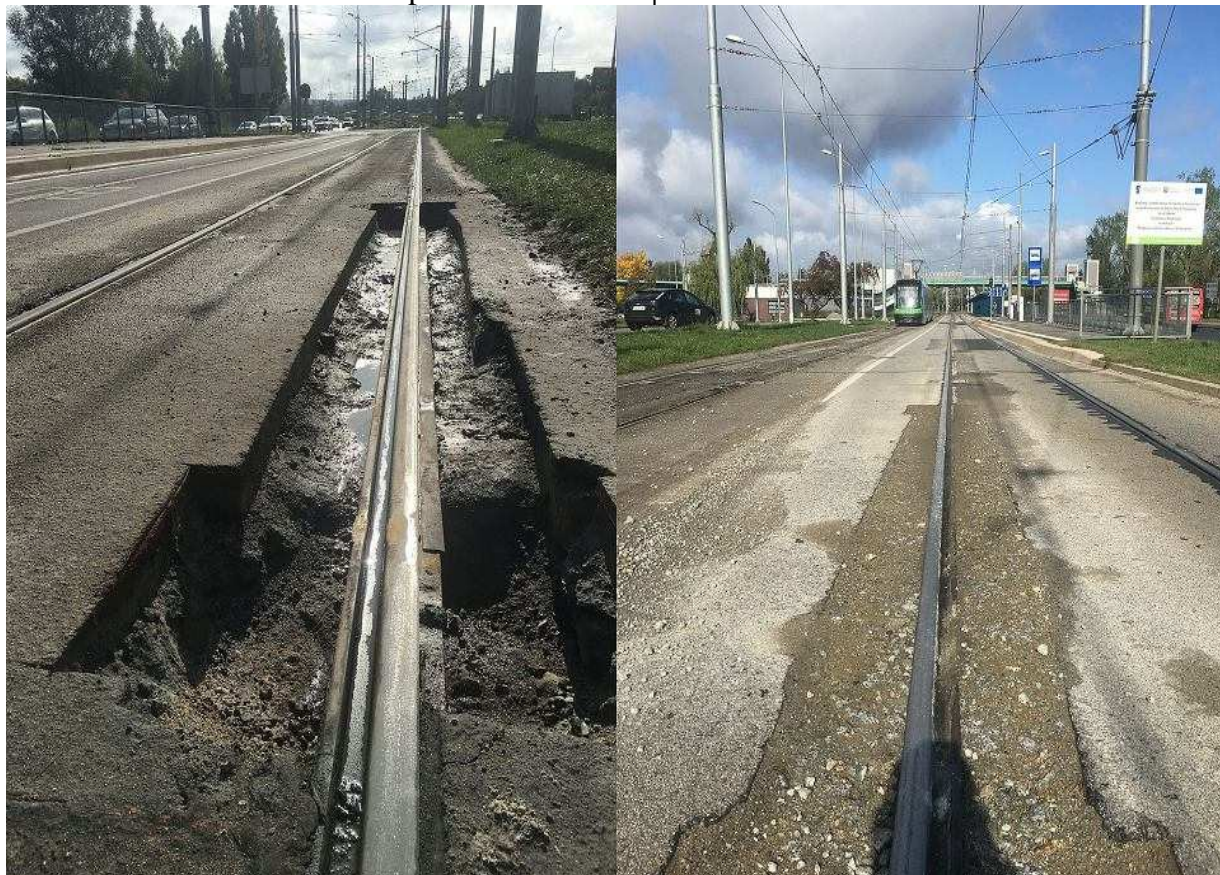
Przygotowania do wycięcia uszkodzonych szyn i wstawienia nowych (Tramwaje Szczecińskie)
