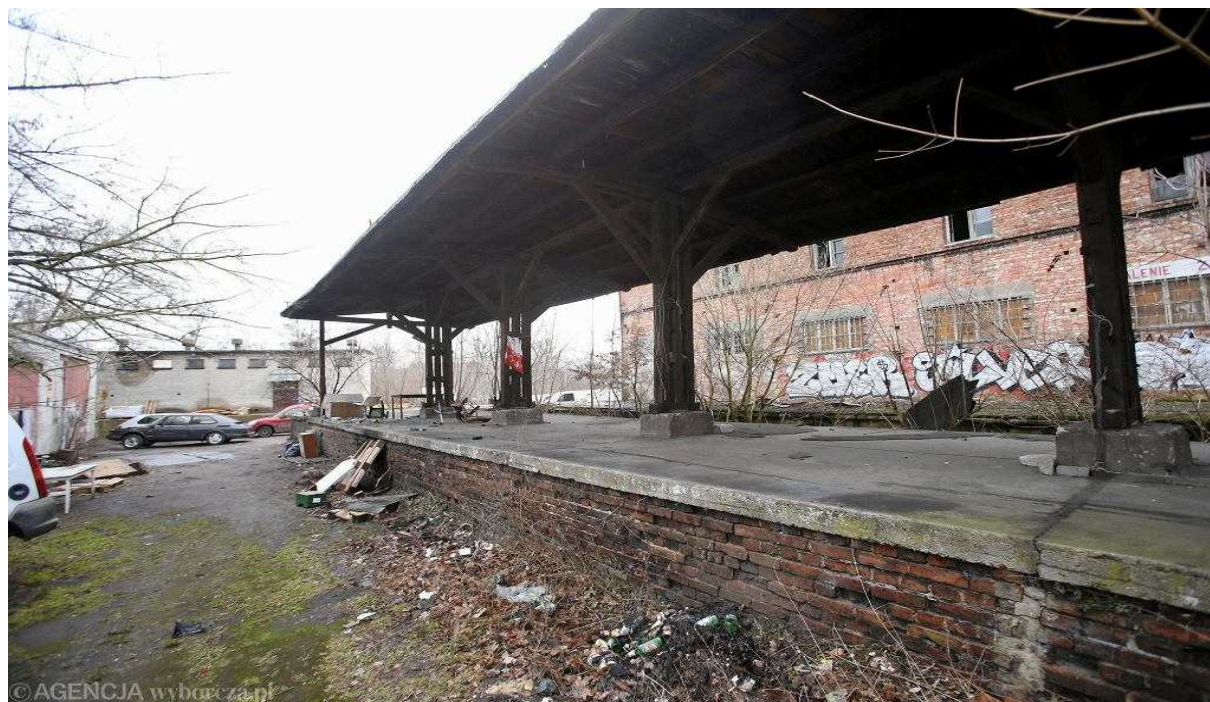
Peron z wiatą na należącym do PKP terenie po dworcu towarowym Pomorzany przy ul. Starkiewicza w Szczecinie w 2022 roku. W tym miejscu powstanie osiedle mieszkaniowe realizowane przez PFR Nieruchomości Fot. Cezary Aszkiełowicz / Agencja Wyborcza.pl
