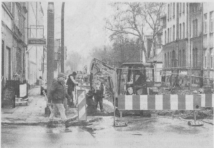
Prace drogowe na skrzyżowaniu z ul. Milczańską
