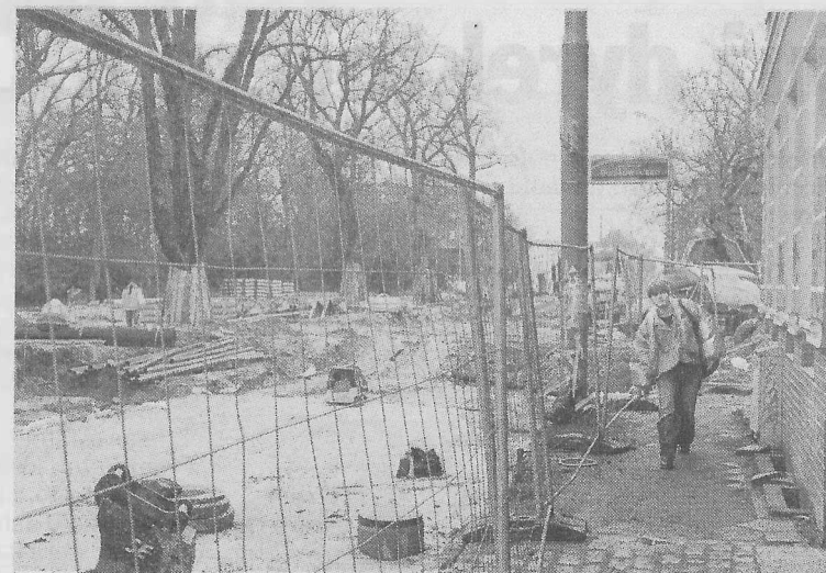
Modernizacja ma potrwać do przyszłego roku.
