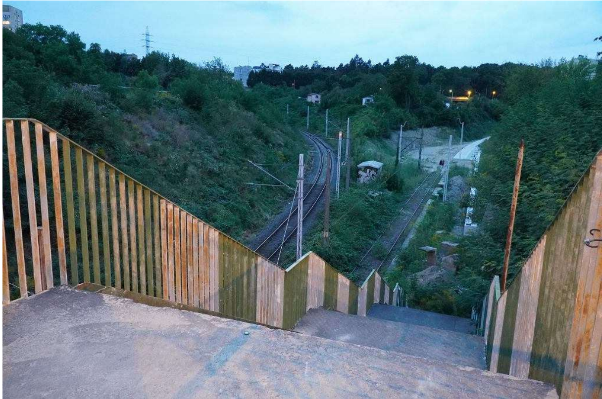
Zejscie z wiaduktu kolejowego w kierunku przebudowywanego przystanku kolejowego 'Pomorzany' fot. Andrzej Krańnicki jr
