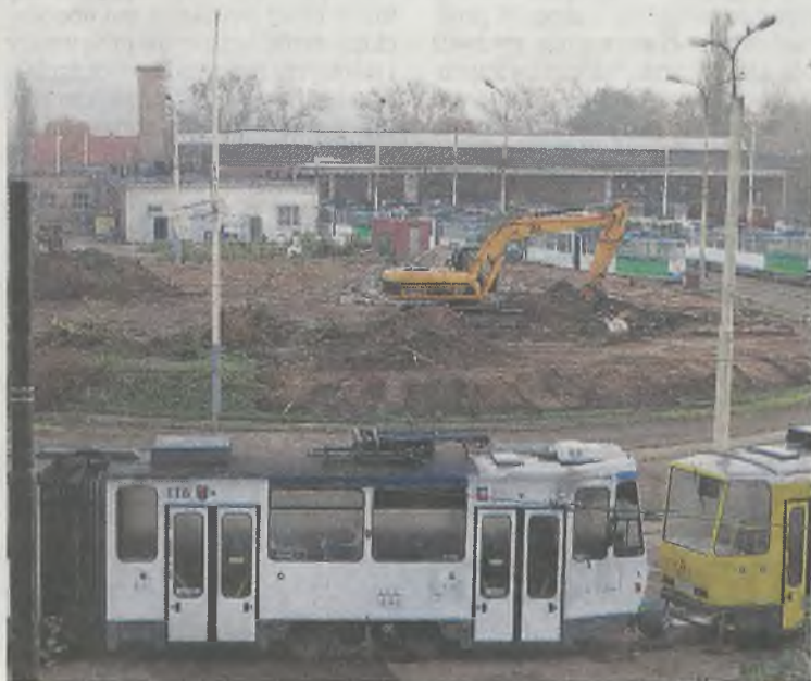
Operacja na „żywym organizmie”, czyli zajezdnia Pogodno w trakcie przebudowy.
