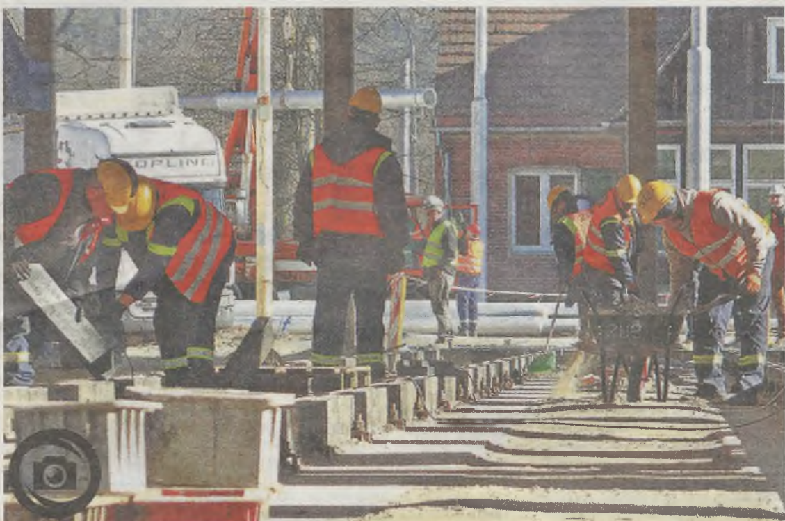
Roboty przy torach w odrestaurowywanej pierwszej z hal kompleksu zajezdni Pogodno. Na jej tyłach stawiana jest teraz stalowa konstrukcja nowej wiaty.
