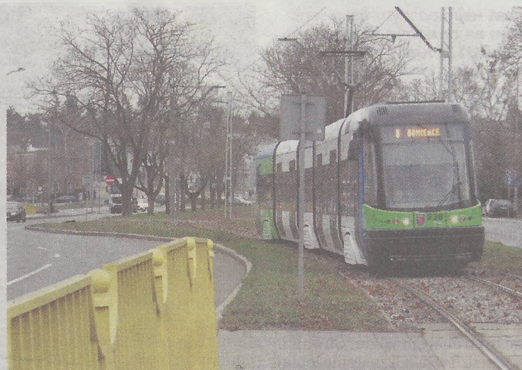
Ul. Ku Słońcu w Szczecinie, odcinek z torowiskiem od ronda Gierosa do pętli przy ul. Kwiatowej
