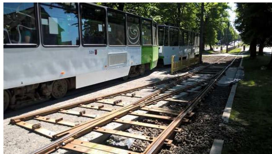
Przygotowania do przebudowy skrzyżowania ulicy Mickiewicza z ulicami Janickiego, Czorszyńską, Reduty Orдона, Wernyhory i Żołnierską Andrzej Kraśnicki jr
