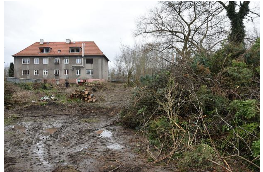
Tu poprowadzone zostaną (w rynnicy) tory kolejowe. W głębi budynek przeznaczony do wyburzenia Andrzej Kraśnicki jr
