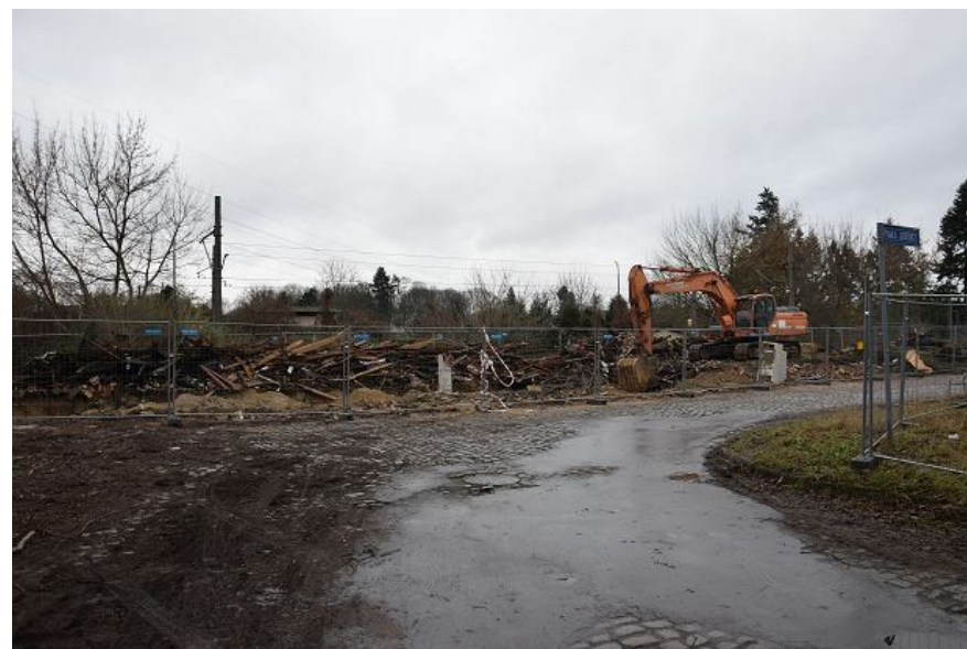
Wyburzony budynek stacji Łęčno Andrzej Kraśnicki jr
