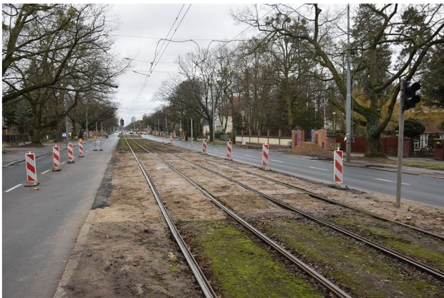
Tymczasowy przejazd z jezdni na jezdnię Andrzej Kraśnicki jr
