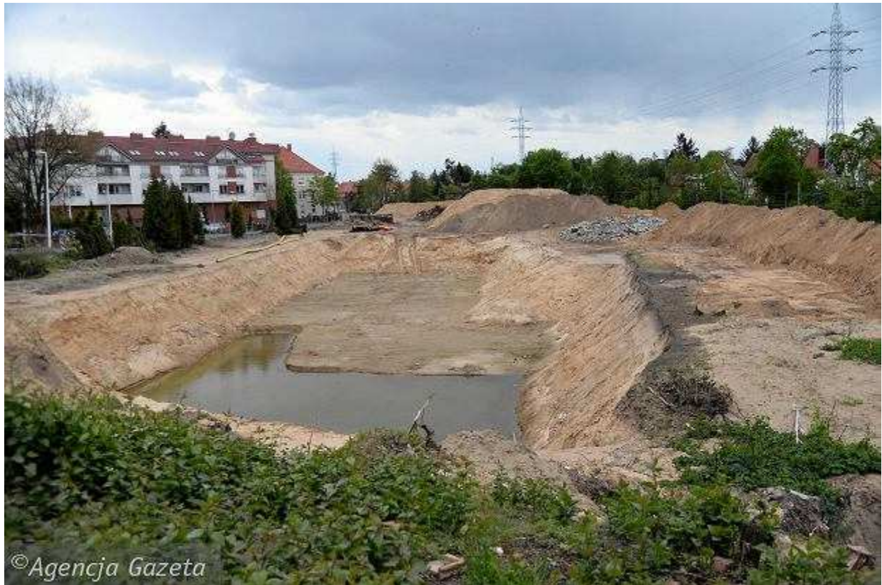
Węzeł Łęknno w budowie na początku maja 2019 r. KRZYSZTOF HADRIAN
