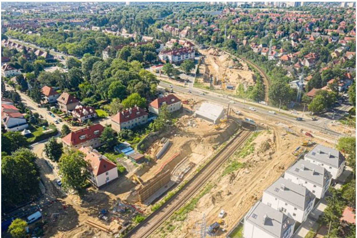
Budowa węzła Łękno Materiały UM Szczecin
