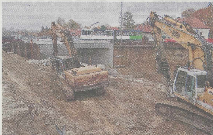
Przebudowa węzła Łękno
