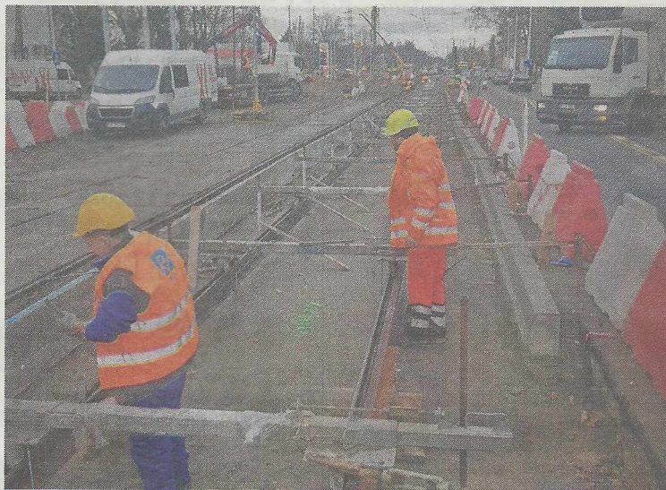
Prace prowadzone są również przy torowisku.
