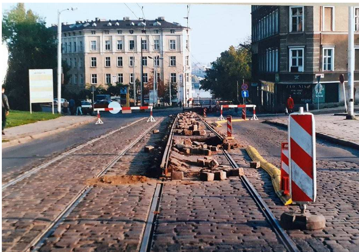
Przebudowa ulicy Dworcowej w 1996 roku Andrzej Kraśnicki jr
