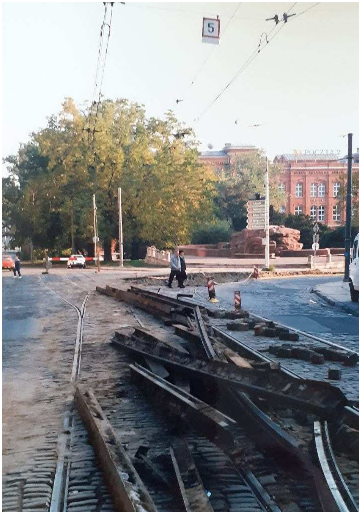
Przebudowa ulicy Dworcowej w 1996 roku Andrzej Kraśnicki jr
